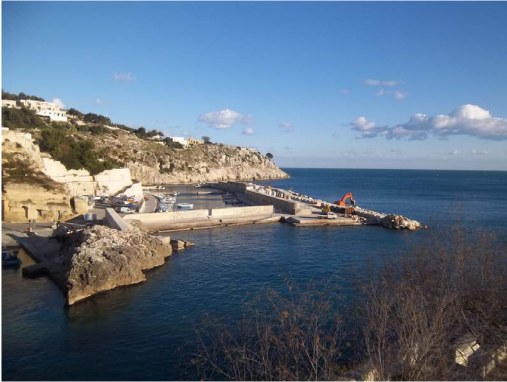
2.1. Consolidamento del molo foraneo e ampliamento della berma - 2012
