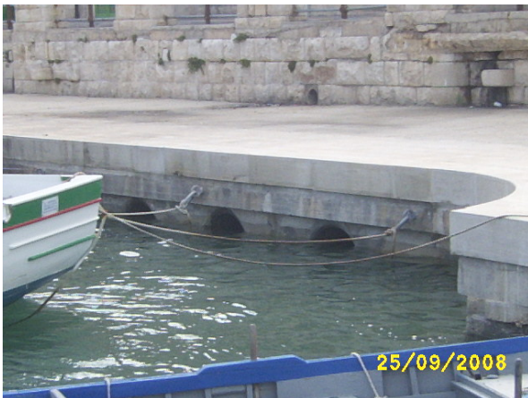
7.5. Dispositivi antirisacca con tubazioni in cls e canalizzazione dei flussi d'aria
