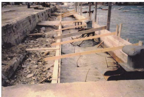
1.1. Costruzione della banchina di riva, al piede della strada di accesso al porto che, sino ad allora, veniva identificato con il solo primo tratto del molo foraneo.
