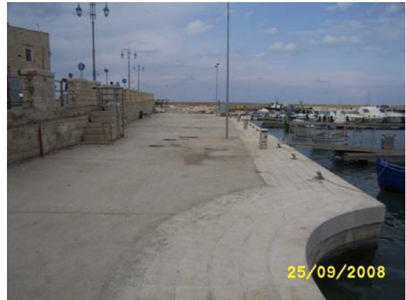
7.4. Sagomatura della banchina per l'eliminazione dei ristagni di materiali galleggianti
