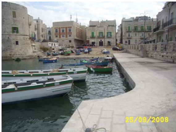
7.4. Sagomatura della banchina per l'eliminazione dei ristagni di materiali galleggianti
