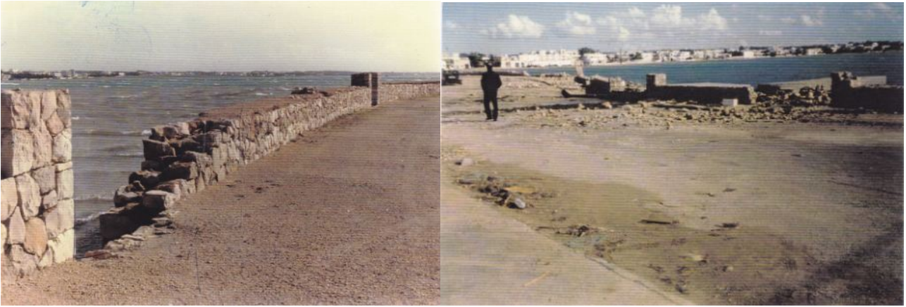
4.5. Riviera di Levante prima dell'intervento
