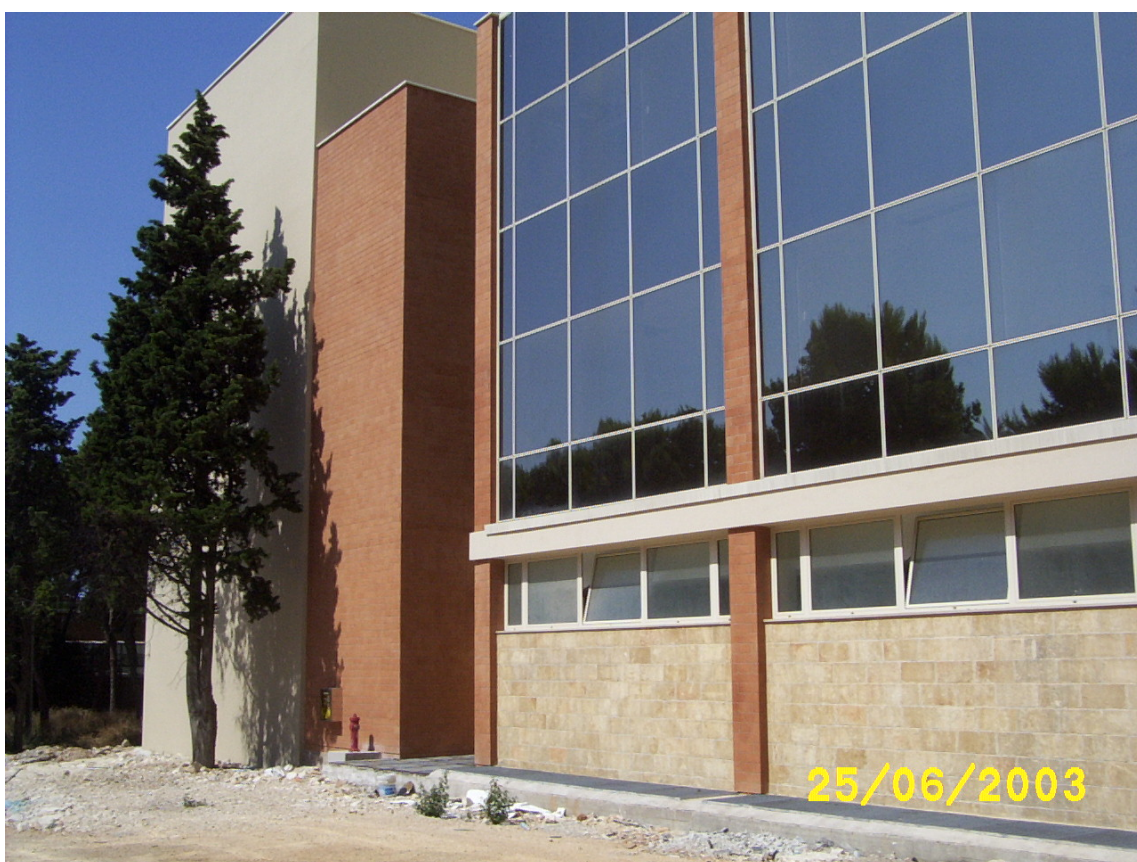
12.8. Particolare del prospetto principale (alberatura in aderenza di cui era stata richiesta la tutela)
